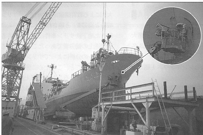
船の修繕：外板の研磨作業 昭和50年代後半頃からの高所作業車の導入により安全性が向上した
